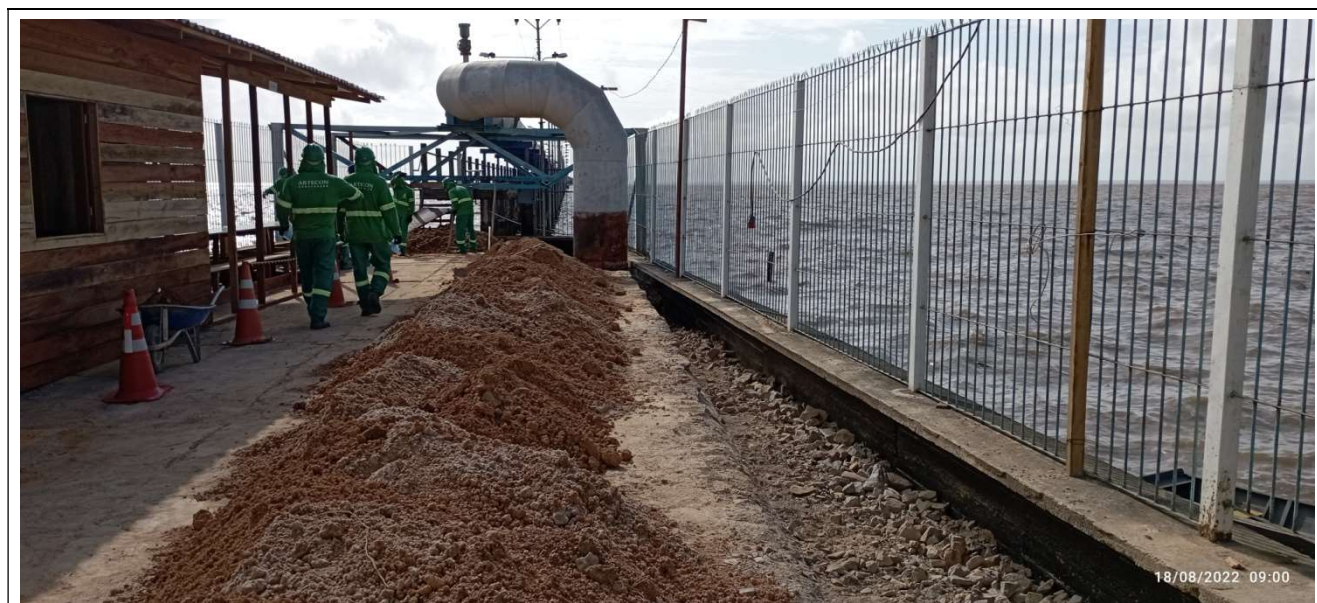
Obra de reforço na estrutura do entrono da adutora
